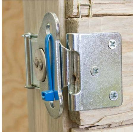
Figura 1.9. Pestillo fijado con bridas.
