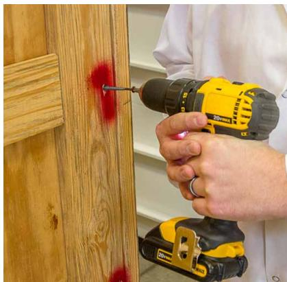
Figura 2.10. Desatornillado del lateral del panel frontal.
